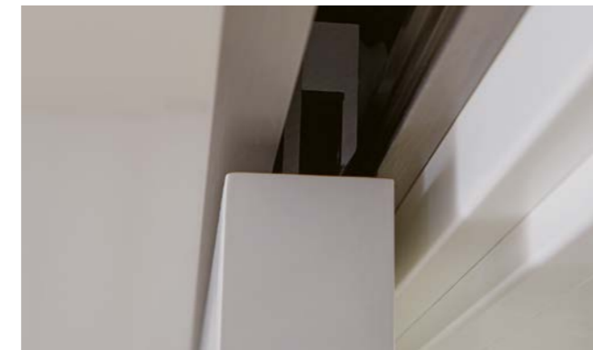
Befestigung einer Holztür im Schiebetürbeschlag SLIM
